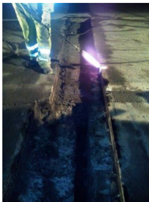
Figura 4. Calentamiento de bordes y fondo del cajeado con lanza térmica
