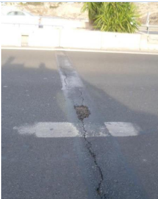
Figura 1. Estado inicial de la junta
