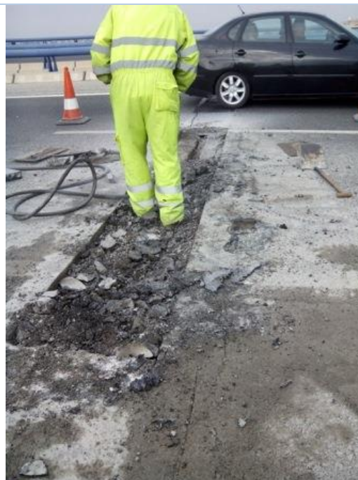
Figura 2. Demolición de la junta deteriorada
