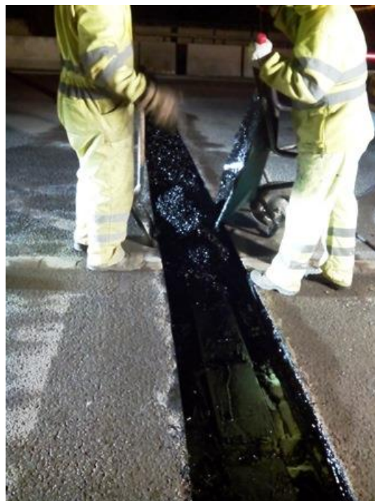
Figura 6. Vertido del mortero bituminoso
