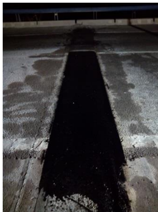
Figura 8. Sellado final con betún modificado con polímeros
