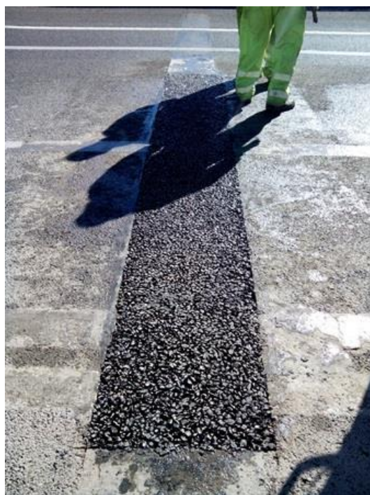
Figura 7. Junta elástica compactada
