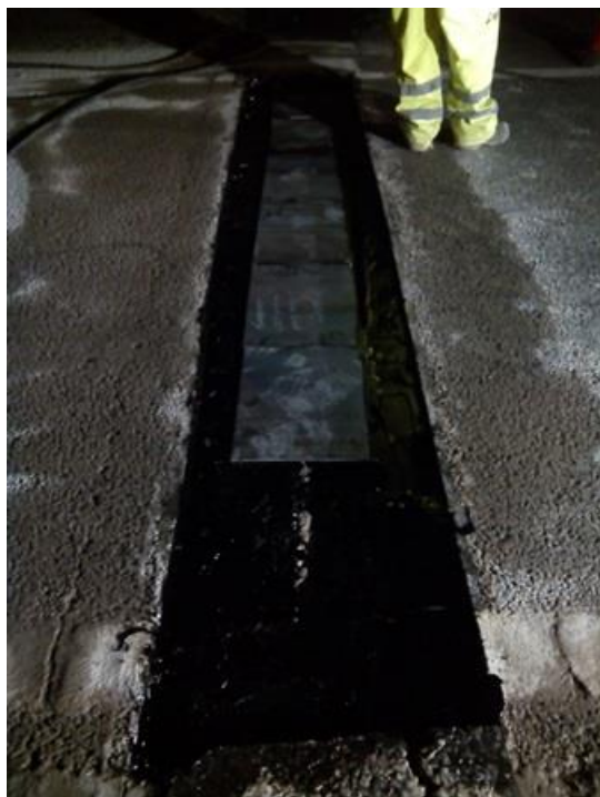
Figura 5. Imprimación del cajeadado con betún modificado con polímeros
