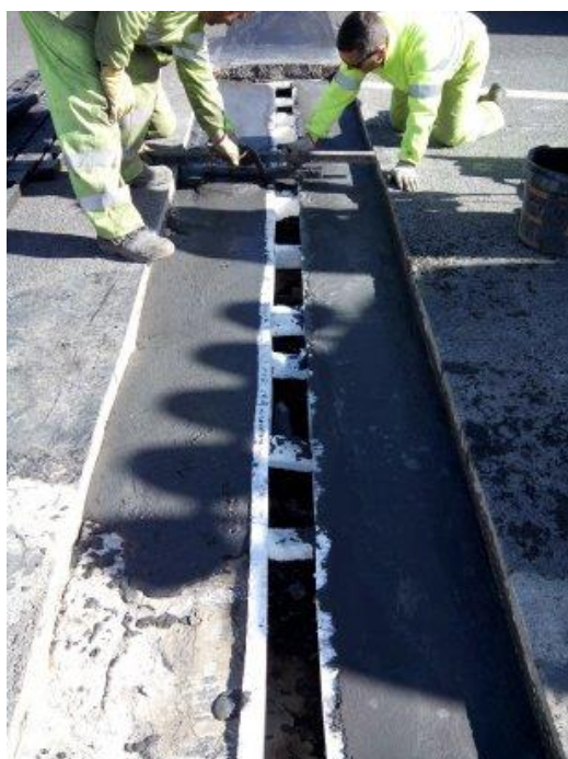
Figura 3. Reparación de bordes del tablero con mortero especial de alta resistencia
